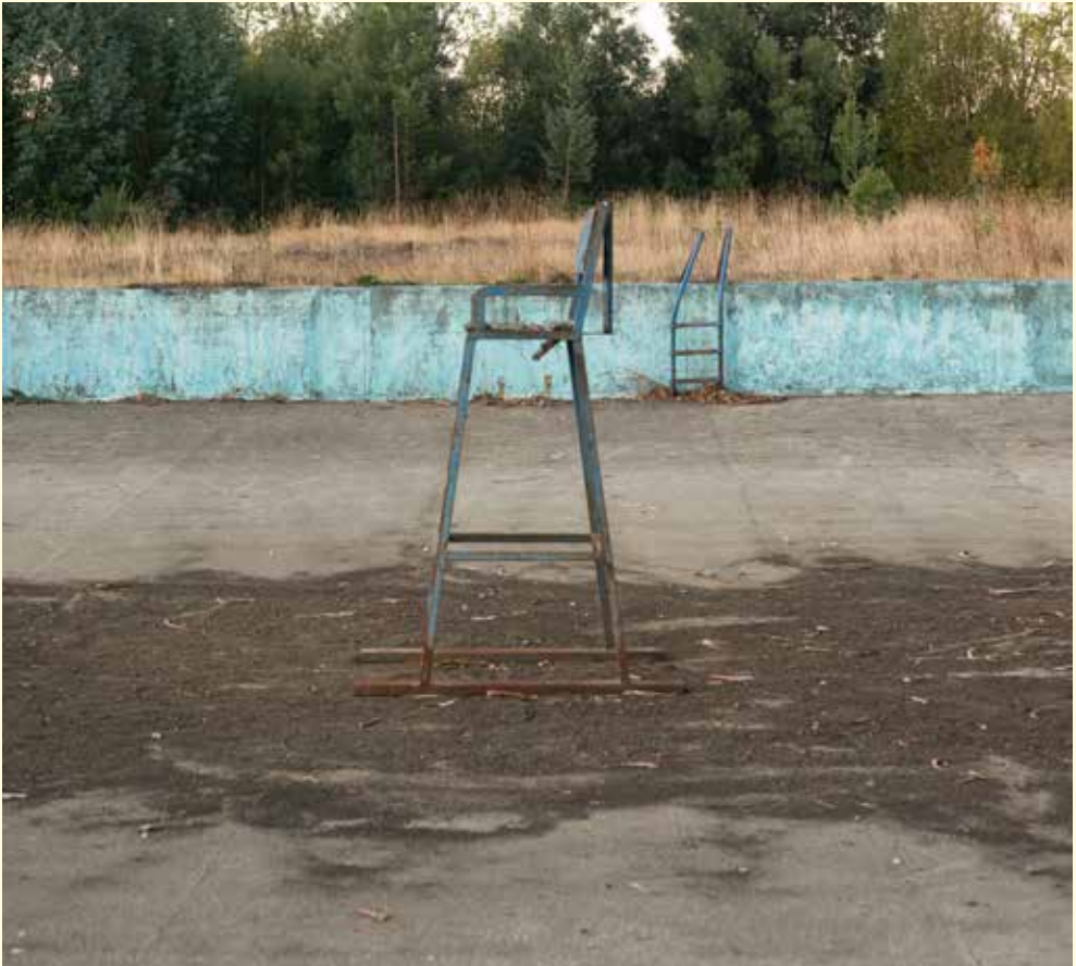
Piscinas vacías en el sector de Las Ánimas, Valdivia.
